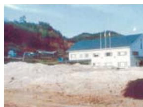
建設中の匠の里
