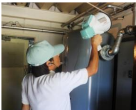
リークディテクターを用いて 小さなエア漏れ音を丹念に探る
