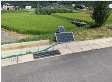
ソーラーパネルを用いて雨水枡から水を汲み上げ
